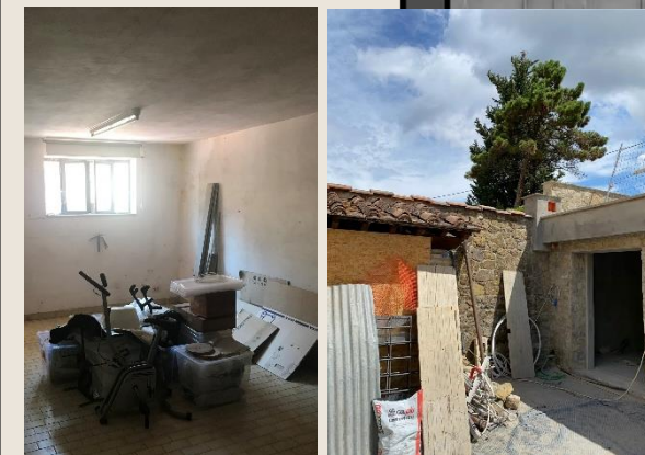
Creazione di una porta al posto della finestra esistente
